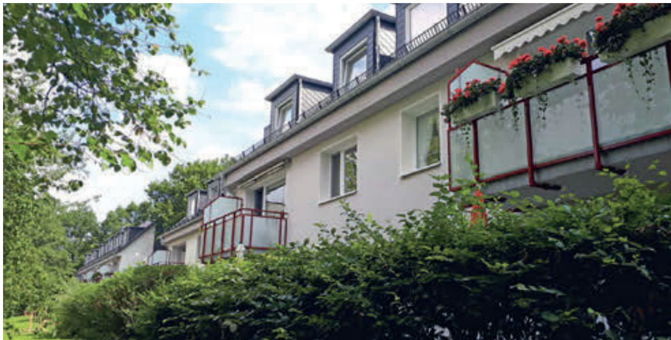
Nach langer Umbauzeit endlich wieder eine Wohnanlage im Grünen: Unsere 26 Wohnungen in der Kopernikusstraße und in der Scharbeutzer Straße/Rahlstedt nach der energetischen Modernisierung 2017.
